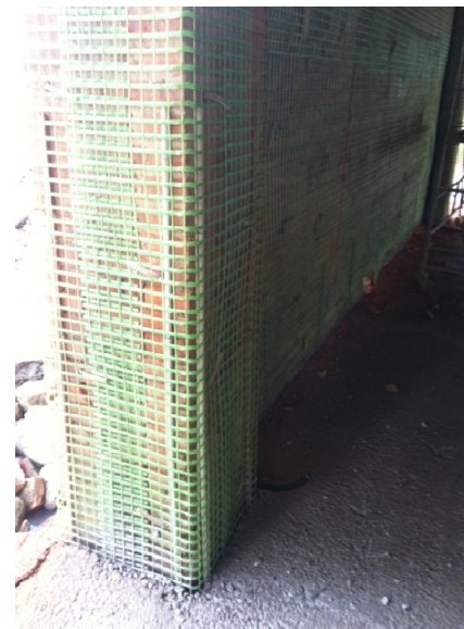
Foto di cantiere: pilastro in muratura da rinforzarsi con intonaco armato e connessioni alle fondazioni
