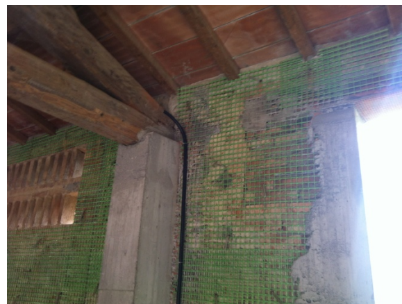
Foto di cantiere: pilastro in c.a. e rete f.r.p. per intonaco armato
