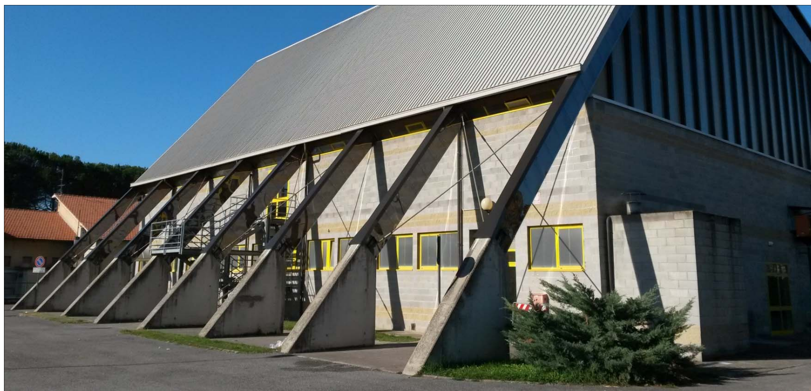
Lato frontale: protezione in lastre tipo Lexan dei puntoni in lamellare
