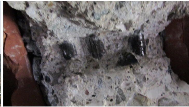
Un saggio sul travetto di solaio esistente
