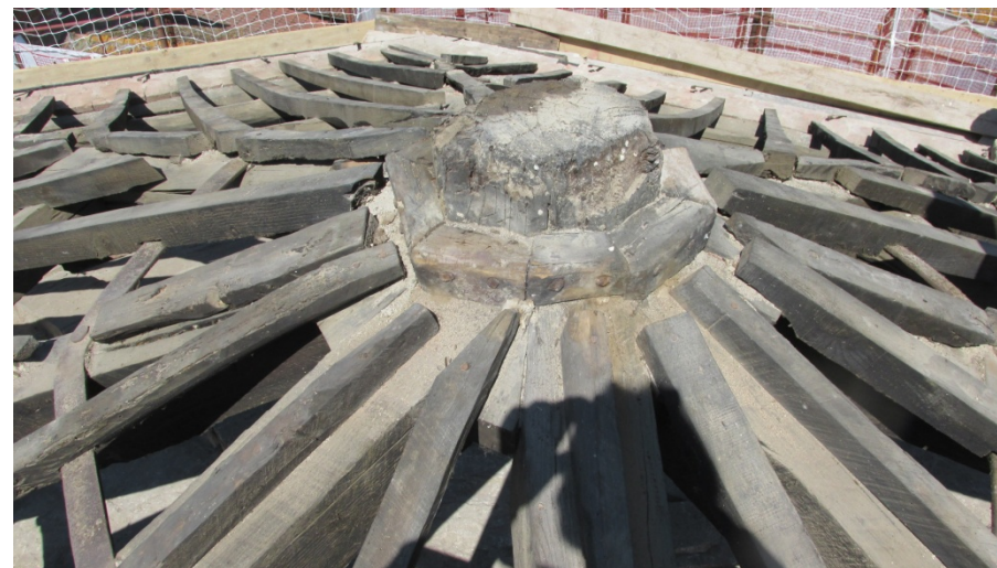
Copertura tamburo ottagonale
