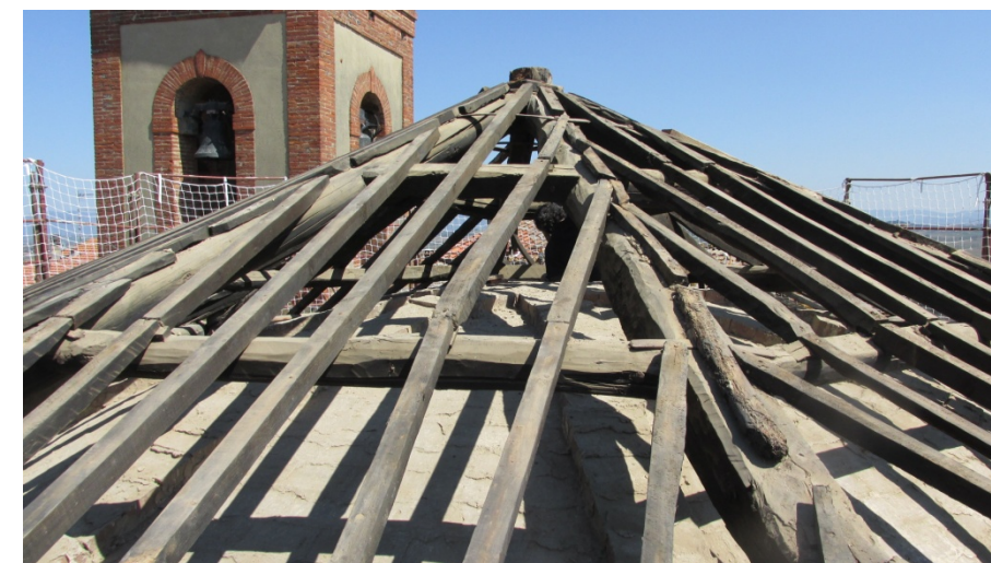
Copertura tamburo ottagonale
