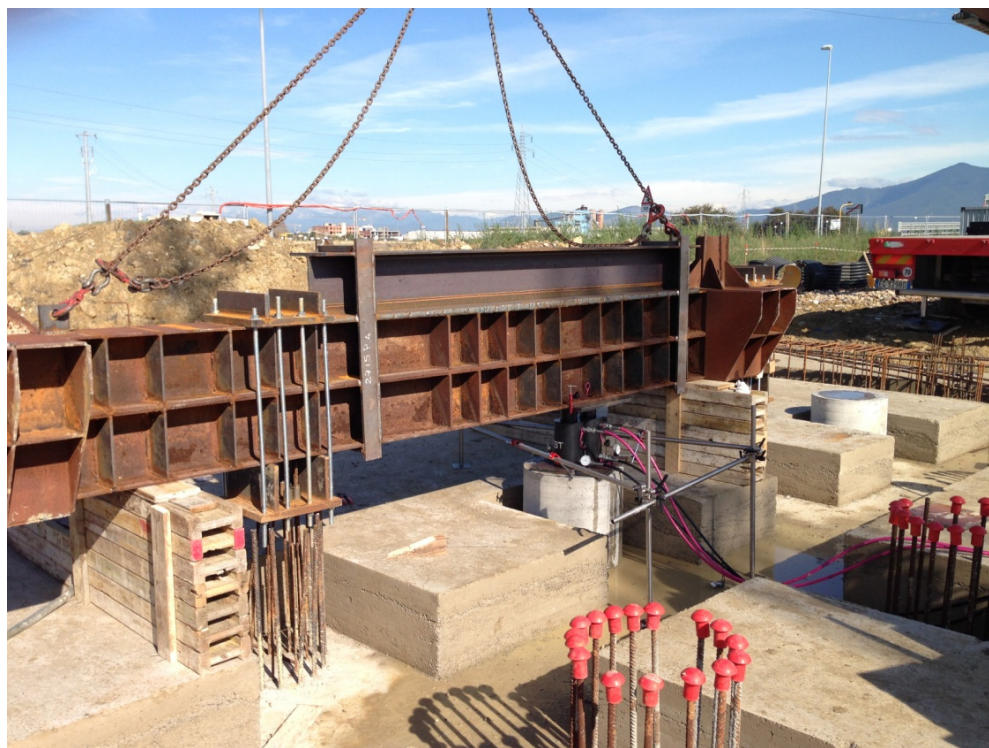
struttura di prova per pali di grosso diametro
