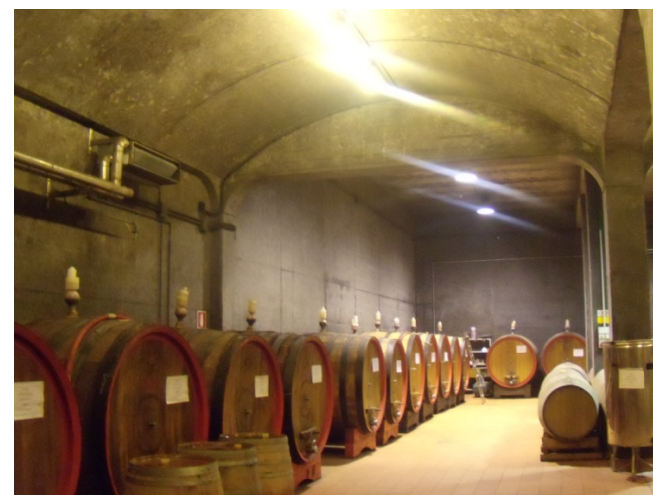
Locale interrato con copertura a volte
