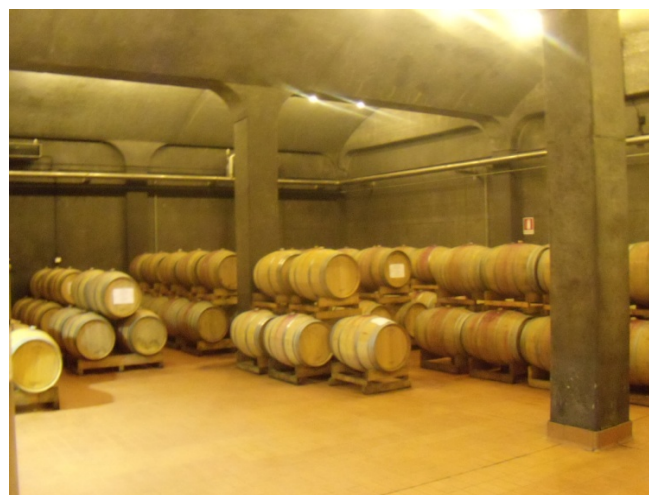
Locale interrato con copertura a volte
