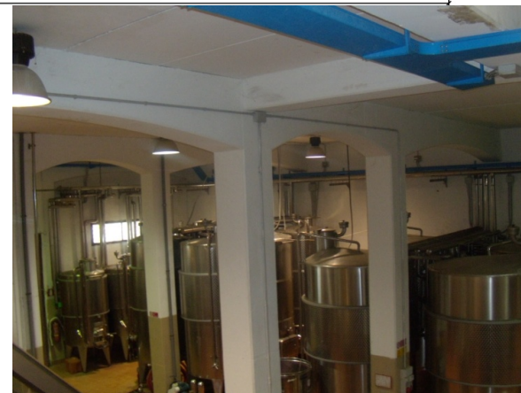
Trave principale 1° solaio
