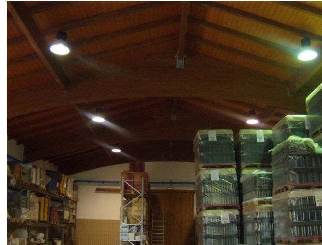
Copertura in legno lamellare
