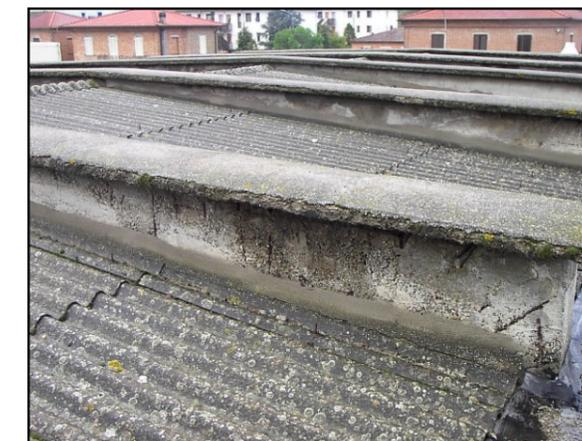
Fig.5: ossidazione delle armature e carbonatazione sulle travi di copertura
