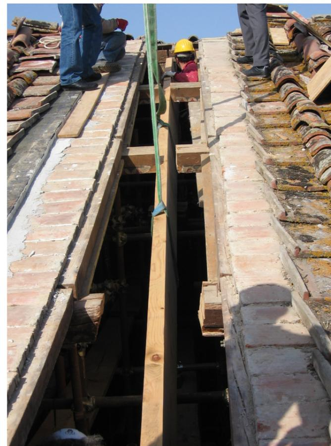
**Figura 9 : sostituzione puntone**
