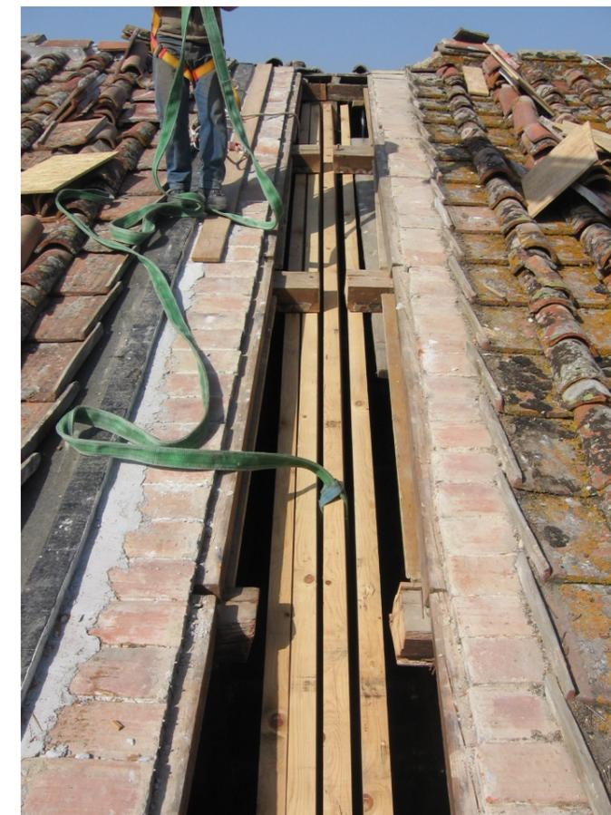
**Figura 10 : sostituzione puntone**
