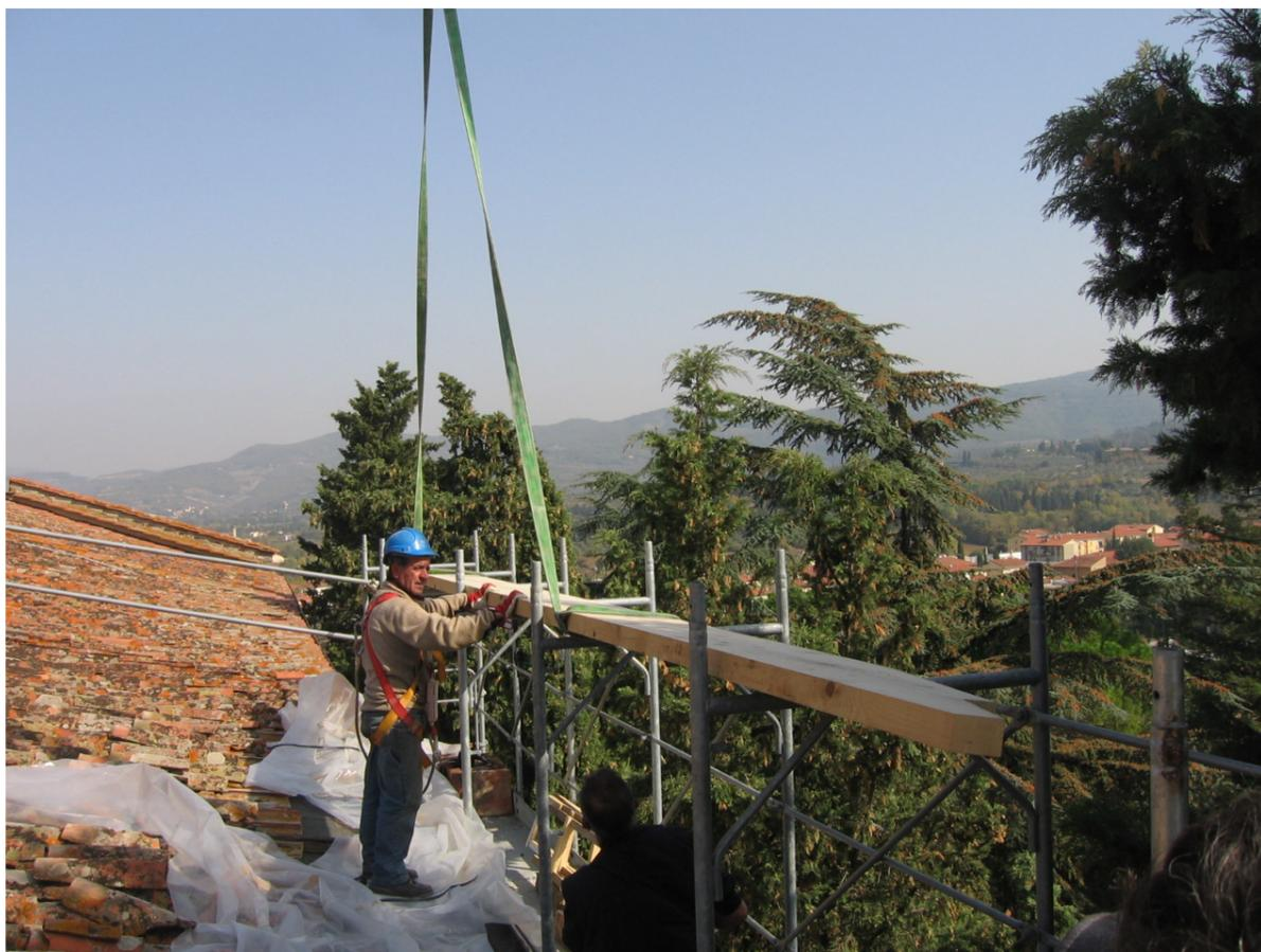
**Figura 8 : sostituzione puntone**
