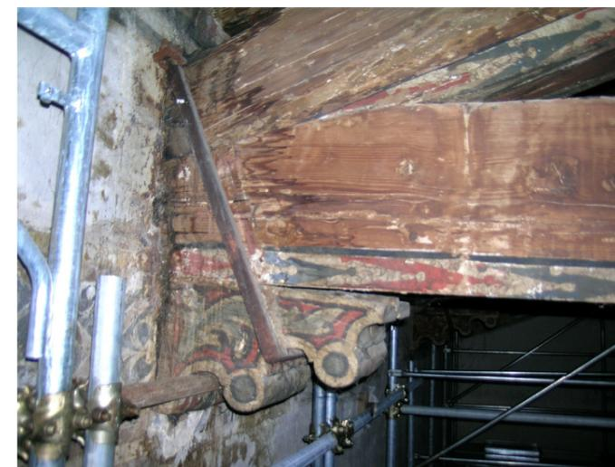
**Figura 7: puntellatura appoggio catena cap.2**
