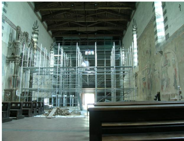
**Figura 5: inizio montaggio ponteggio**
