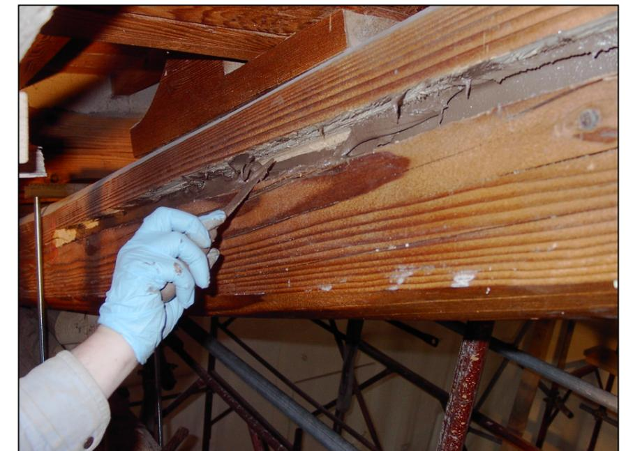
Inserimento di barre fissate con resina epossidica sul puntone
