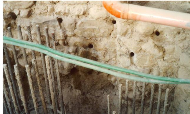
Figura 10: armatura pali e fori per ancoraggi alla muratura
