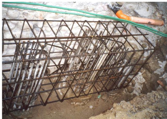
Figura 12: armatura pali e cordolo testa pali
