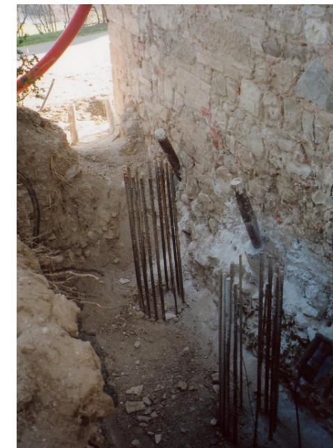
Figura 9: armatura pali e micropali inclinati
