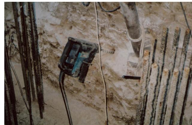
Figura 8: armatura pali di grosso diametro, fori collegamento cord-muratura
