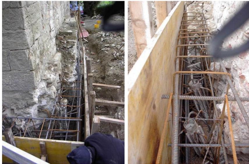
Figura 6: armatura cordolo testa micropali sx
