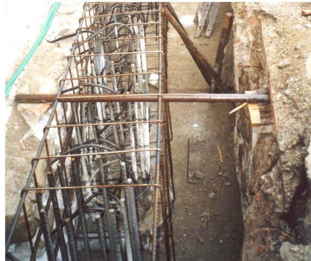
Figura 11: armatura pali, ancoraggi alla muratura e cordolo testa pali
