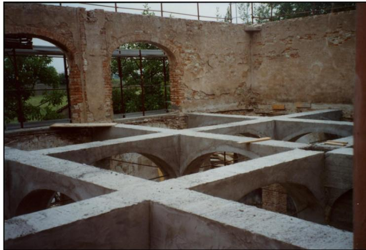
Figura 4: consolidamento del sistema di archi.
