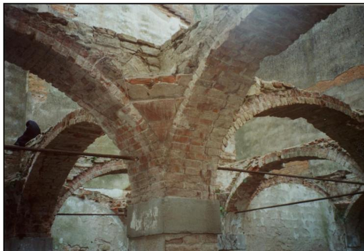
Figura 2: solaio crollato nella zona delle volte.
