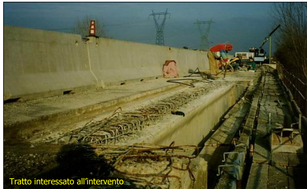
Particolare posizionamento armatura ancoraggio barriere
