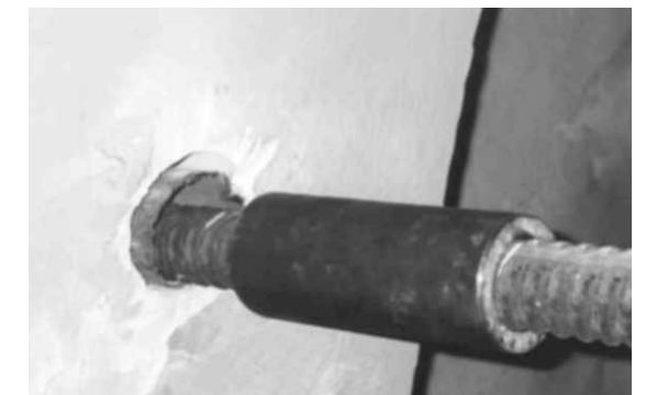
Giunzione catena archi principali
