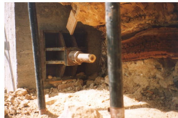
Ancoraggio catena archi principali (VECCHIA CATENA LIGNEA)
