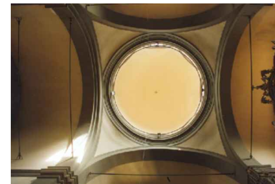
Sistema degli archi sul tamburo al termine del consolidamento
