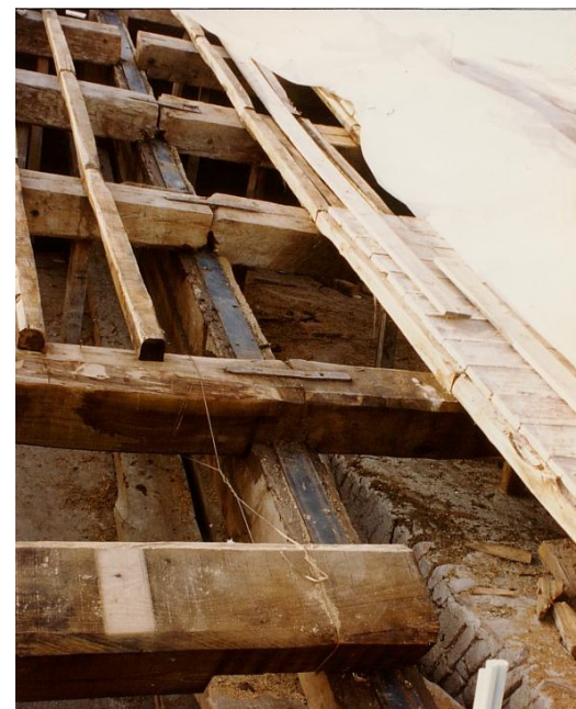
Consolidamento con acciaio su puntone
