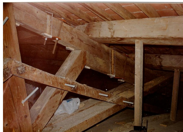
Stuccatura fessure con barre di vetroresina e resina epossidica
